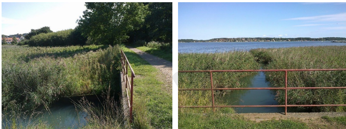
Billeder af udløbspunkt for regnvand fra Rebæk
